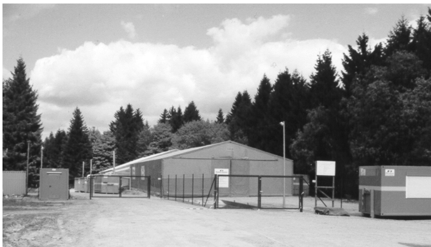
Abb. 1: Pilotanlage am Standort "Werk Tanne" bei Clausthal-Zellerfeld (Foto: IABG)
